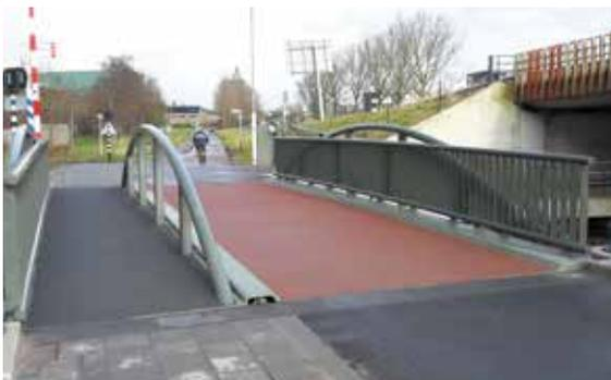
Mit seinen langlebigen und wartungsfreien Eigenschaften ist die JCB anderen Brücken, die aus Holz, Stahl und Beton gebaut werden, weitaus überlegen. Es lässt sich eine reelle maximale freie Spannweite von 40 Meter realisieren. Was die Breite betrifft, gibt es keine Einschränkungen, da die verschiedenen Elemente aneinander gekoppelt werden können.
